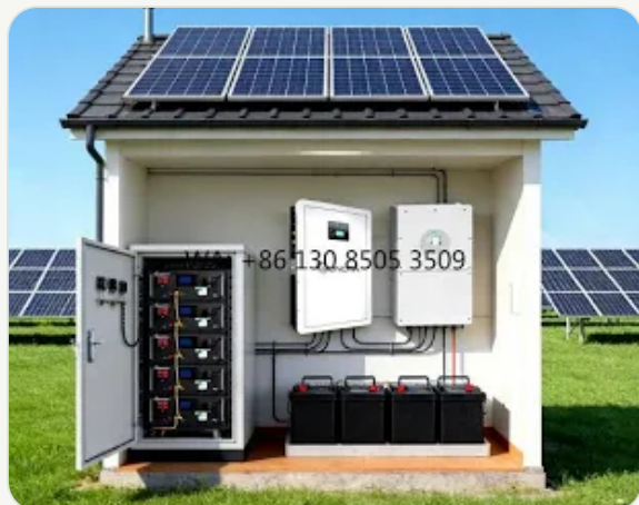
Przykładowa instalacja PV z magazynem energii. Zdjęcie ilustracyjne.
