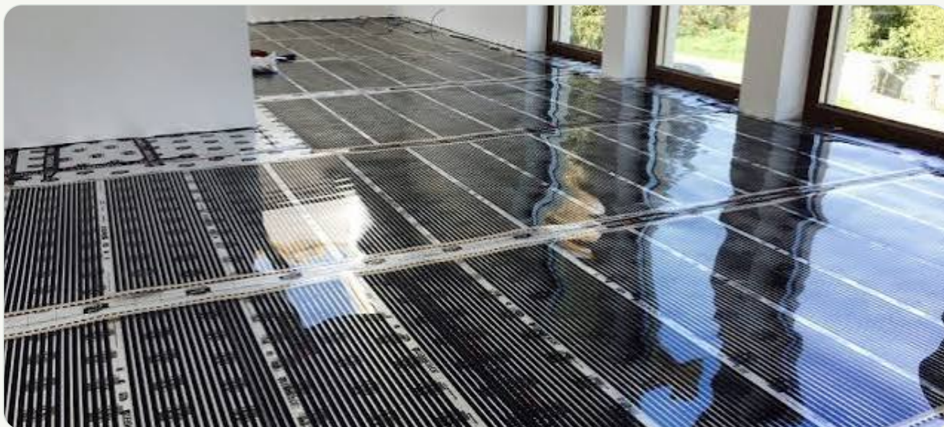
Przykładowa instalacja folii grzewczej pod posadzką. Zdjęcie ilustracyjne.
